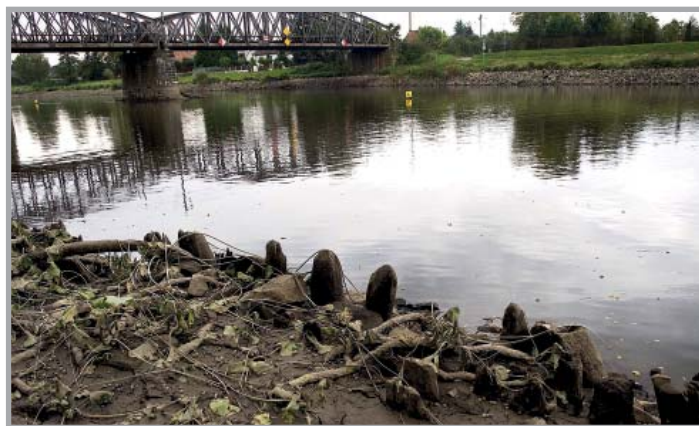
Pozůstatky jezu (hlavy pilot) pod mostem, rok 2012. Foto: soukromá sbírka
