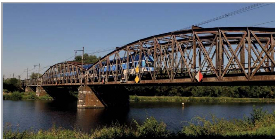
Železniční most (rok 2016), který by po více než sto letech měl nahradit most nový. Foto: Kamil Voděra , www.ceska-mesta.cz
