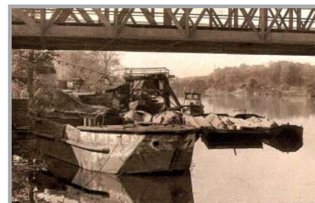
Překladiště písku pod mostem v 50. letech 20. století. Foto: soukromá sbírka
