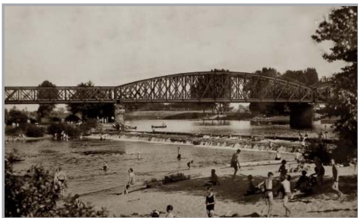
Jez pod mostem ve 30. letech 20. století. Foto: soukromá sbírka
