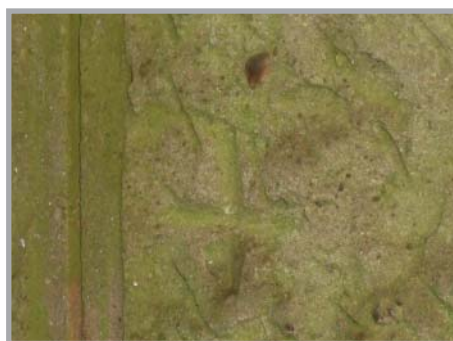
Místa k uložení náloží označená křížky v pilířích na pravém břehu Labe. Foto: -iv-
