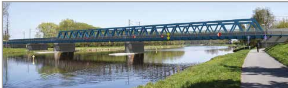
Než bude postavena nova dvoukolejná konstrukce mostu přes řeku Labe, budou vlaky jezdit po jednokolejném mostním provizoriu. Zdroj: Metropojekt, SUDOP Praha
