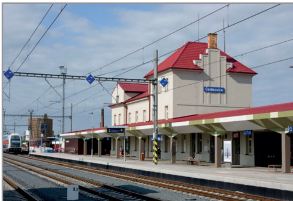
Výpravní budova žst. Čelákovice s vnějším nástupištěm po dokončení stavby Modernizace žst. Čelákovice v červnu 2019 – pohled od severovýchodu. Zdroj: Správa železniční dopravní cesty
